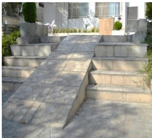
تصویر ۵: شیب سطح شیب‌دار در حیاط پشتی خانه سالمندان شماره ۲، آن را برای استفاده مستقل، نامناسب می‌سازد؛ نگارنده
